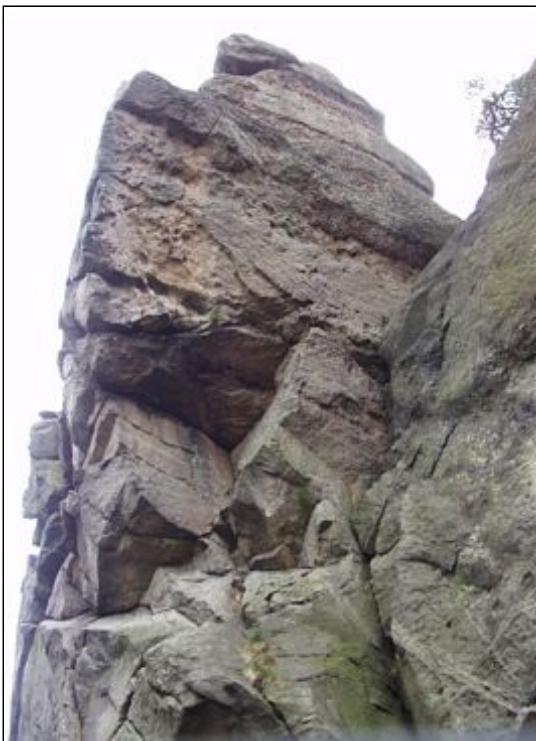
Obr.1: Šachtová věž II. východní - Z hrana
