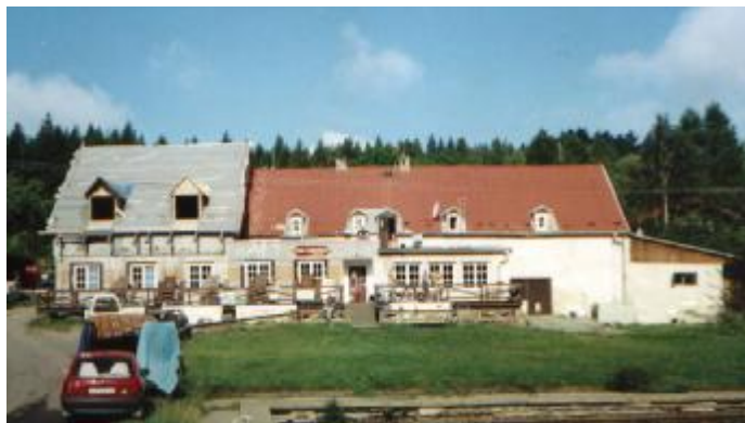
Na snímku restaurace Pod Císařem s ještě rozestavěnou střechou.
